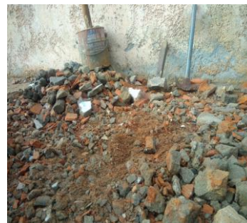
Figura2- Trituração do residuo Fonte: Arquivo pessoal
