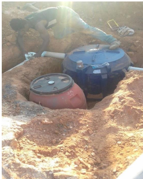
Figura 01: DUARTE S. – Instalação BIODIGESTOR. Colocação válvula de retenção. Fazenda Tamboril Tapira - MG
