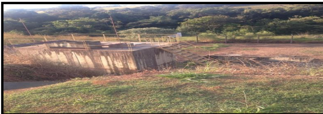
Figura 2: ETE Camuá. Fonte: Arquivo pessoal do autor.
