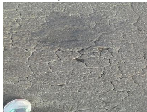
Figura 7a: Trinca tipo “bloco” MG-146 Figura 7b: Trinca tipo “bloco” MG-428
