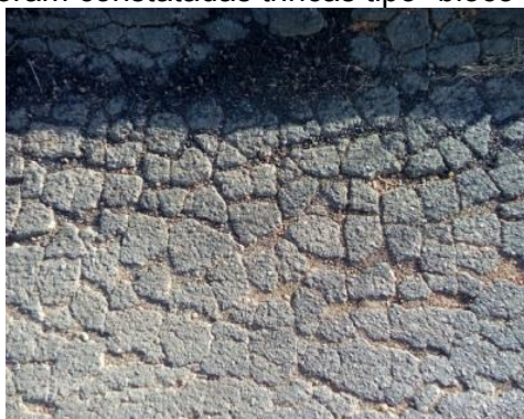
Figura 7a: Trinca tipo “bloco” MG-146 Figura 7b: Trinca tipo “bloco” MG-428
