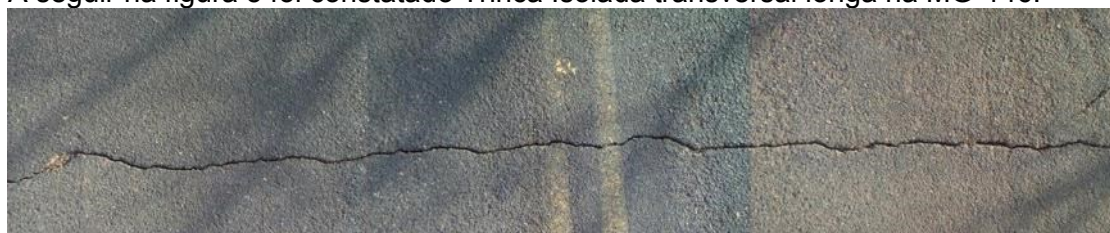
Figura 5: Trinca Isolada transversal longa MG-146
